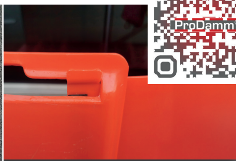
3. Verbindungsanker oben einrasten
